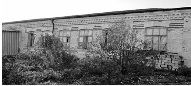
Старая часть школы (сначала вход в неё был с противоположной северной стороны).
